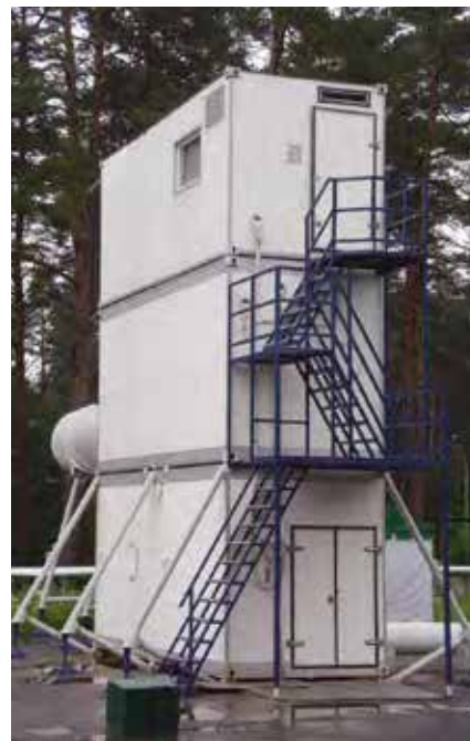
Общий вид МФУТК на базе 20-футовых контейнеров MFLTF General View
