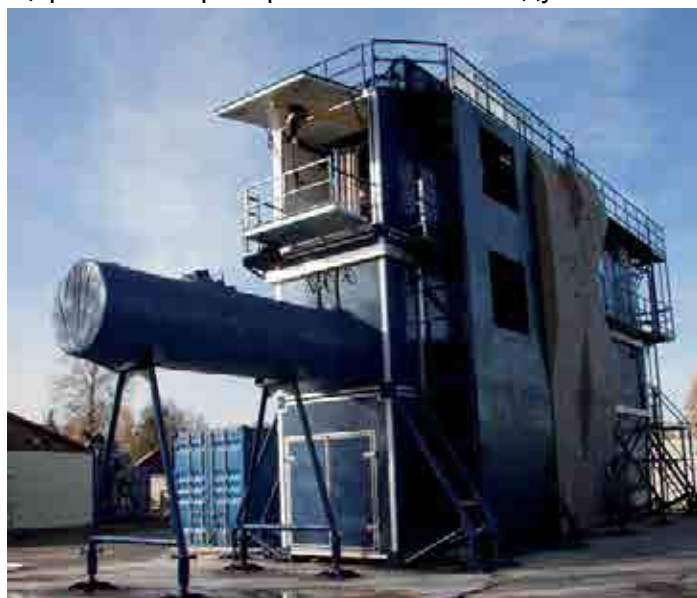
МФУТК на базе 45-тифутовых контейнеров
