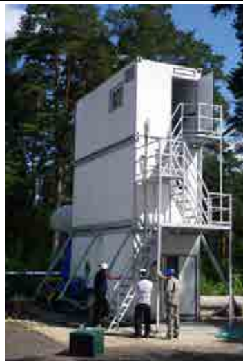
Общий вид МФУТК на базе 20-тифутовых контейнеров
