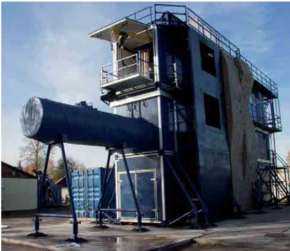
МФУТК на базе 45-тифутовых контейнеров
