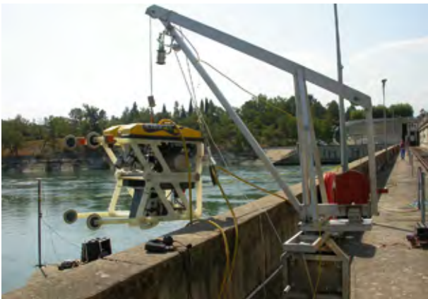
Рис. 1. ТПА Н300 в комплектации для инспекции гидротехнических сооружений
